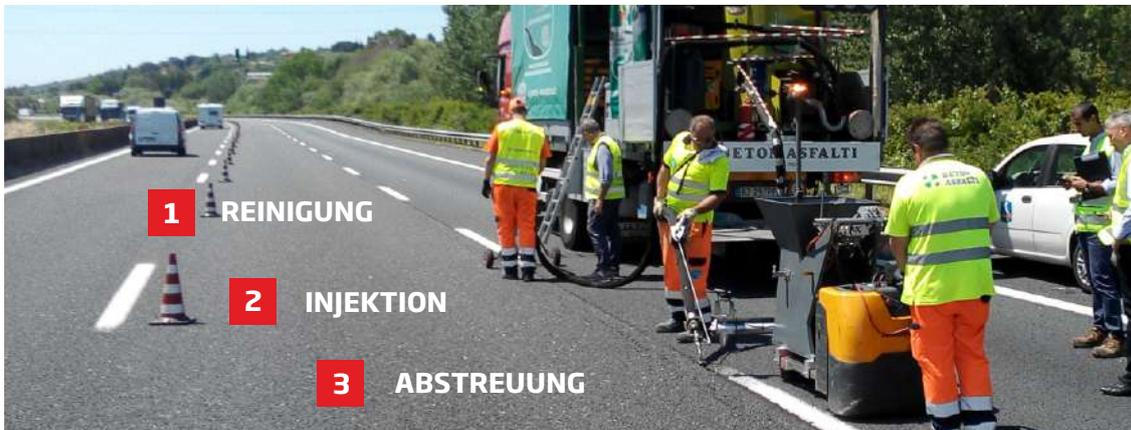
**SBS Sigil PLUS** ist ein Verfahren zur Heißversiegelung von Quer- und Längsrissen im Straßenbelag. Für diesen Einsatz wird eine in ihrer Art einzigartige mobile Anlage verwendet. Dadurch wird eine hohe Produktivität, rasche Ausführung der Baustellen, einfacher Transport sowie große Mobilität gewährleistet. Mit dieser mobilen Anlage arbeiten wir in ganz Italien, einschließlich der Inseln sowie in Mitteleuropa.
