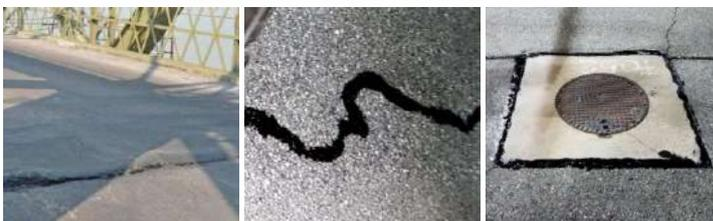
**SigilRapid Plus** ist ein monokomponentes kaltes und elastisches Versiegelungsmittel, ideal zum Abdichten von bituminösen Bodenbelägen und CLS. Eignet sich besonders für die manuelle Auffüllung der Fugen mit rascher Oberflächenvernetzung. Zertifiziert für Flughafenbodenbeläge.
